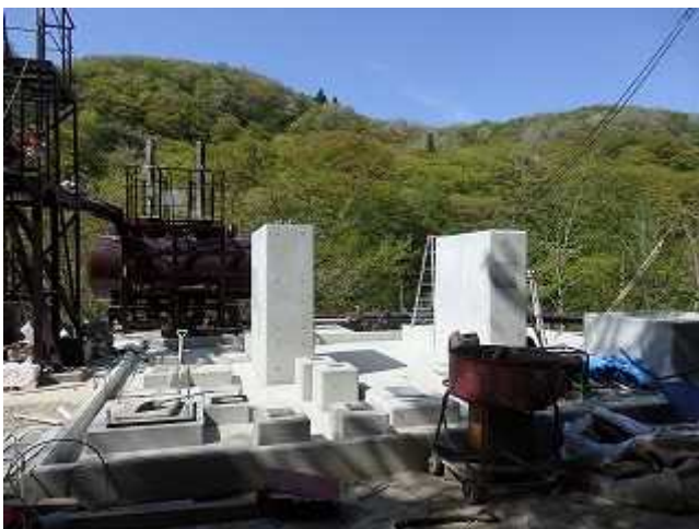
(平成27年4月末の工事状況)
