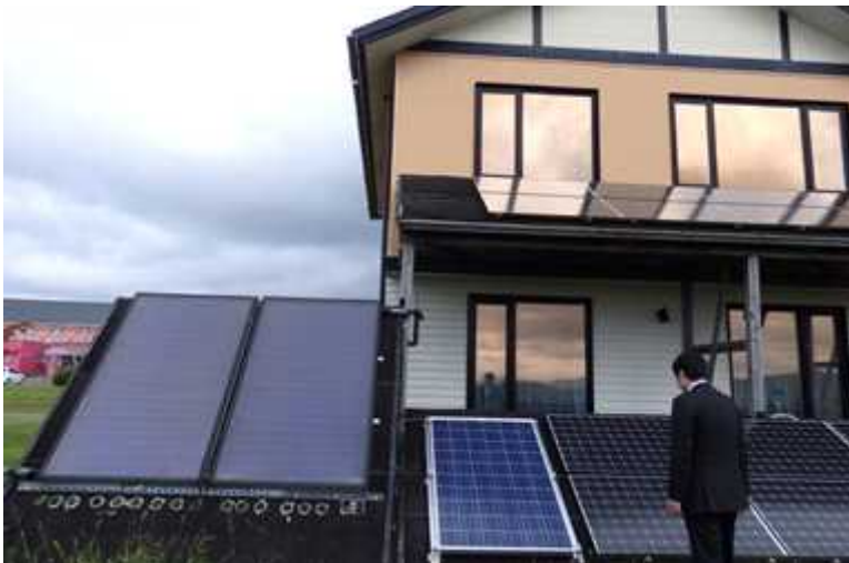
(外観：太陽光パネル、太陽熱温水器)
