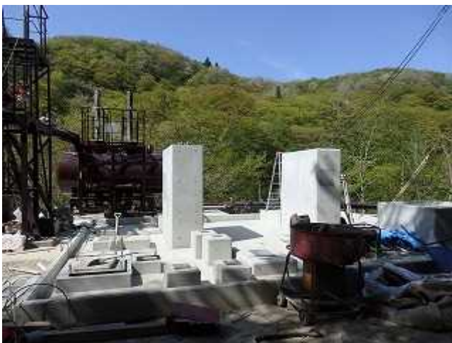
(平成27年4月末の工事状況)
