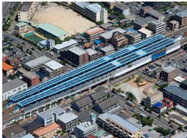
図2-2-4 妙典駅の太陽光発電システムの例
